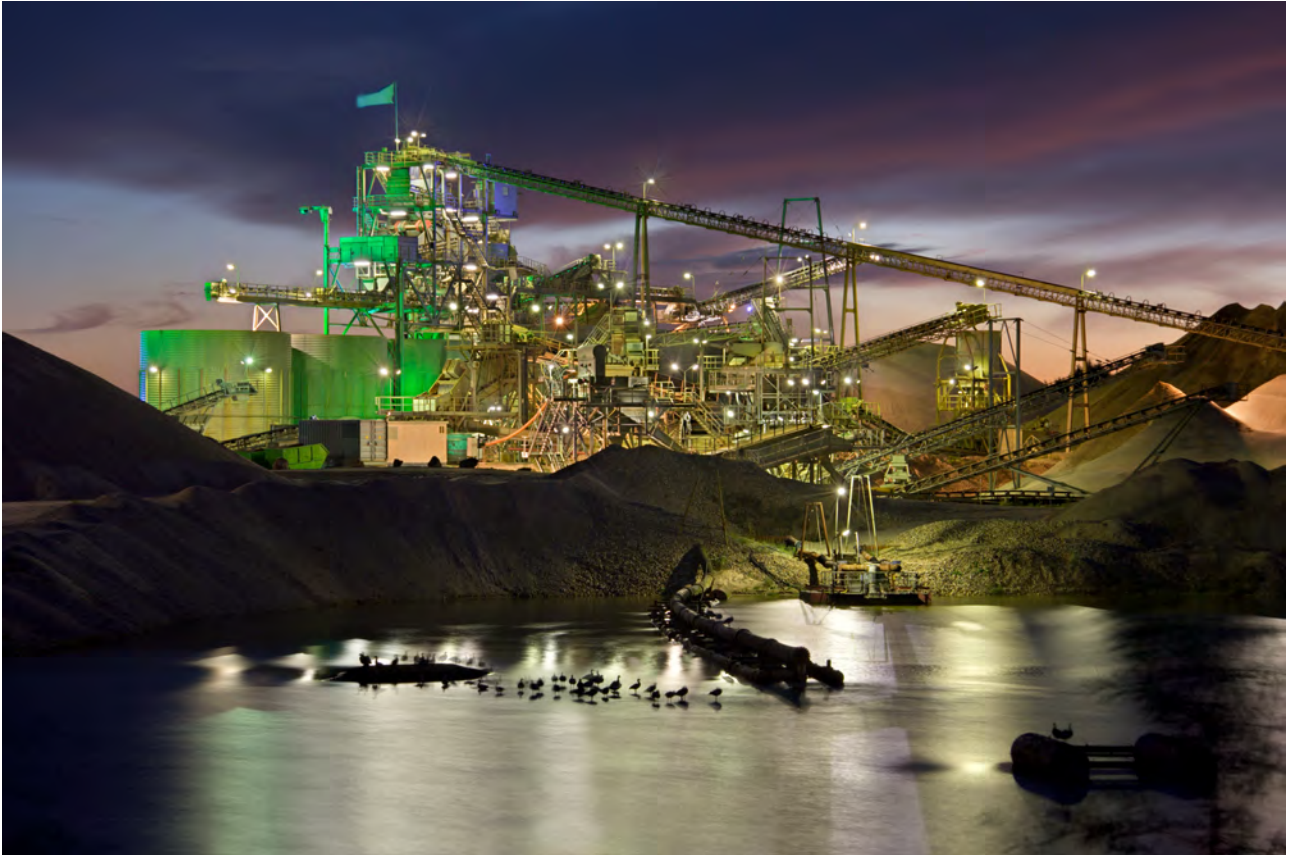
Figure 1. Les grandes installations industrielles contenant des moteurs et d'autres charges réactives en fonctionnement constant ou presque constant (comme les grands convoyeurs de l'usine minière dans la figure ci-dessus) bénéficient grandement de la correction du facteur de puissance.
