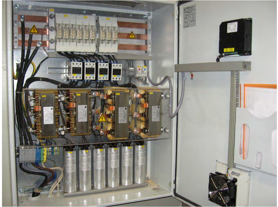
Figure 12. Exemple d'une unité de correction du facteur de puissance utilisée pour la correction du facteur de puissance à l'échelle de l'usine. Notez la banque de condensateurs située au bas de l'appareil.
