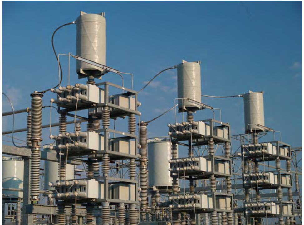
Figure 6. Banque de condensateurs utilisée pour la correction du facteur de puissance.
